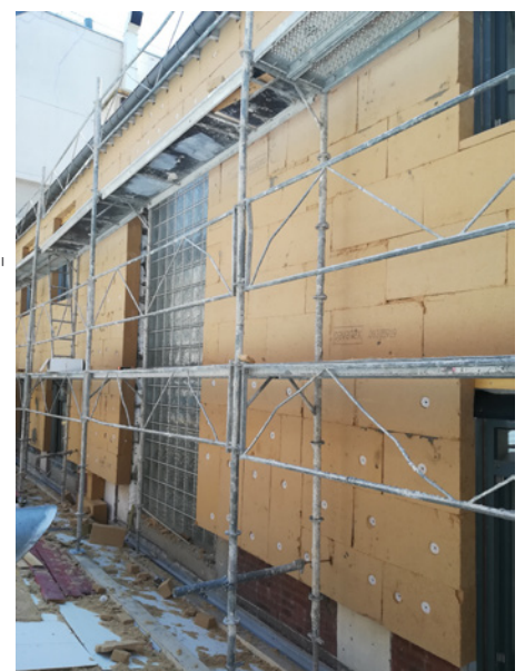
ITE sur cour en panneaux de laine de bois (Pavatex).
