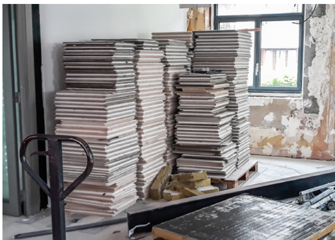
Dalles de plafond récupérées pour leur réemploi sur site
