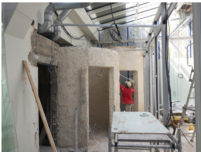
Mise en oeuvre de l'enduit chaux-chanvre
