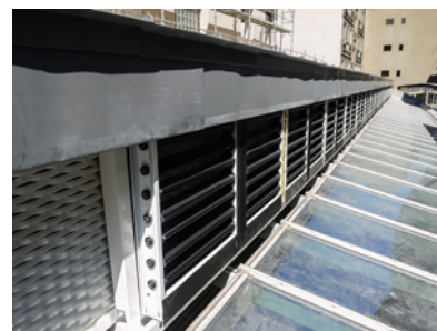
Shed de ventilation naturelle en cours de travaux
