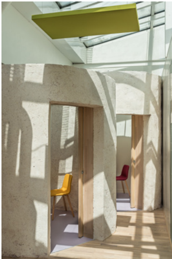
Alcoves en maçonnerie lourde pour augmenter l'inertie du bâti
