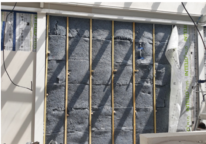
ITI sur rue en coton recyclé (Métisse) avec montants en bois (non en aluminium) et freine vapeur
